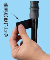
防水パテテープ 取り付け工法
