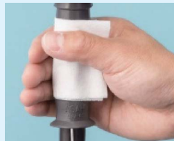
折り戻し部の清掃作業
