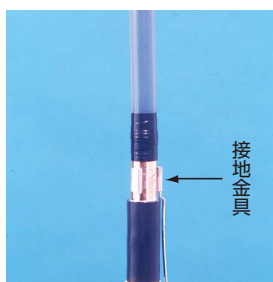
② 接地金具の取付
