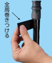
防水パテテープ 取り付け工法
