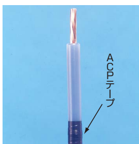
①ケーブルの段はぎ及びACPテープ巻き
