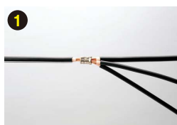
ケーブル処理後導体接続
