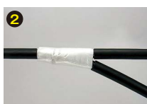
耐火テープの巻き付け
