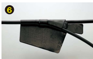
保護シートの巻き付け
