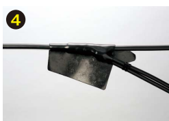
保護シートの巻き付け
