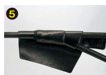
保護シートの巻き付け
