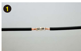
ケーブル処理後導体接続
