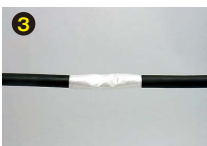
耐火テープの巻き付け
