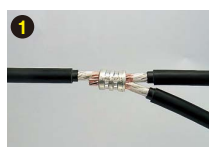
ケーブル処理後導体接続
