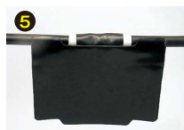
保護シートの巻き付け
